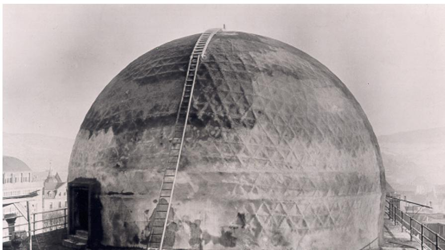
*Foto: Cobrindo a primeira cúpula com ferrocimento*
