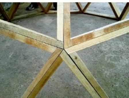
*Método sem conexão*
